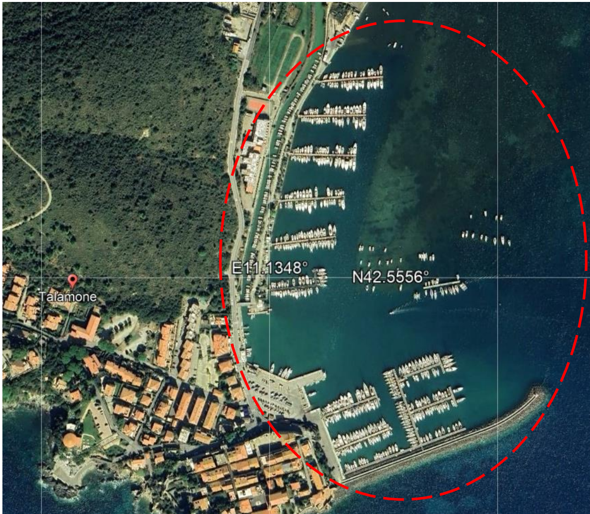
Figura 1. Area oggetto dei lavori
