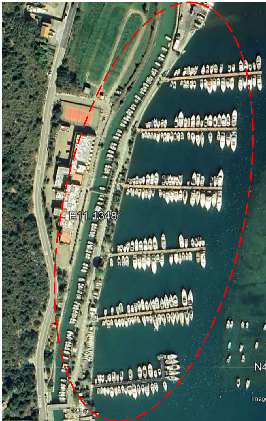
Figura 3. Area nord oggetto dei lavori
